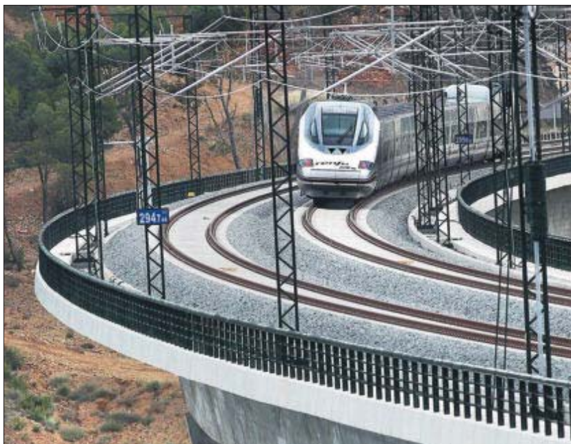
Un tren AVE Madrid-Valencia, a su paso por uno de los viaductos del pantano de Contreras. /CARLES FRANCESC
